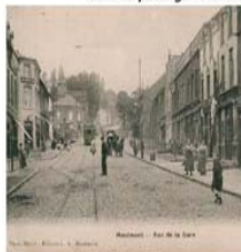
- HAUTMONT - Rue de la gare et sa voie de croisement
