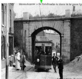
... et posons sous le pont du chemin de fer de la ligne Paris à Bruxelles,
